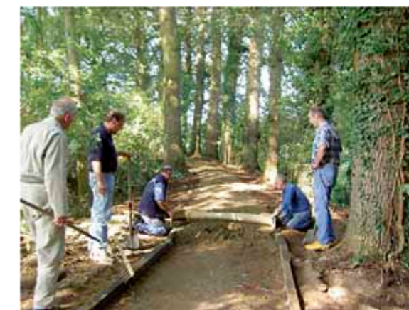
Aanleg Welsinkpad: de 'handmatige' profielbalk
