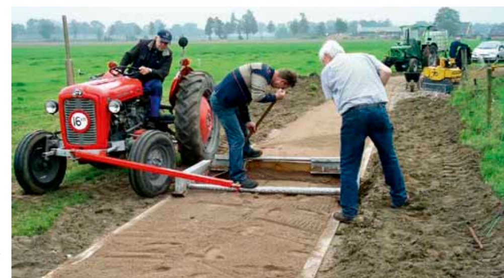
Aanleg Ziegenbeekpad: de gemechaniseerde profielbalk van Bennie en Joop maakt het werk een stuk gemakkelijker.
