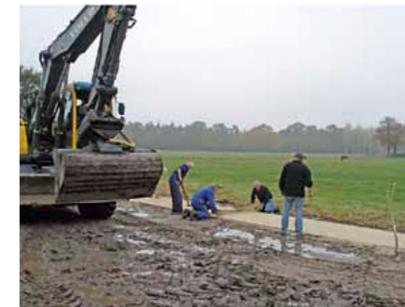
Aanleg Welsinkpad: de 'handmatige' profielbalk
